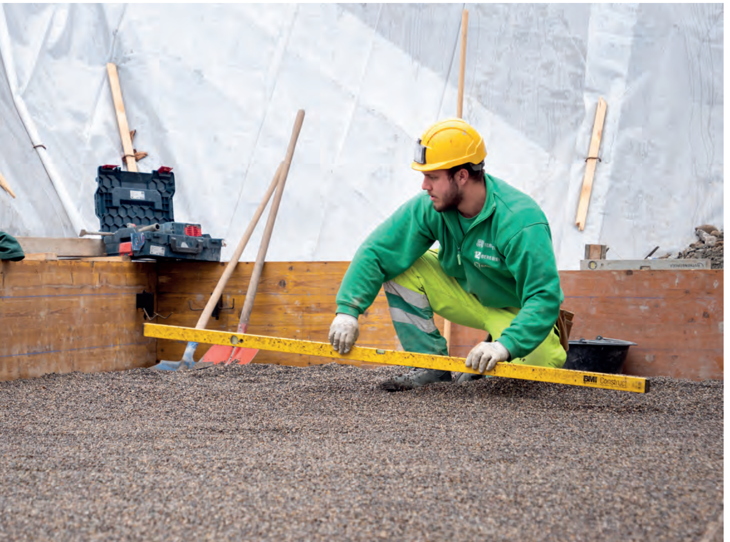
Fabian Duss kümmert sich um die ebene Splittausgleichsschicht.
