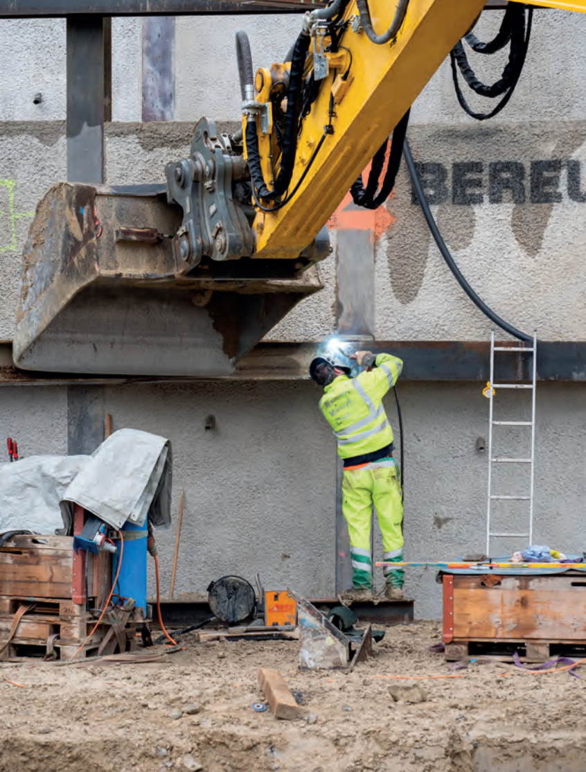
Der Bagger dient nicht nur für den groben Aushub, sondern auch für die millimetergenaue Justierung der Stahlträger.
